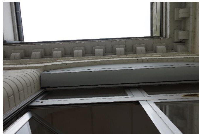
Détails des ébrasements arrondis
